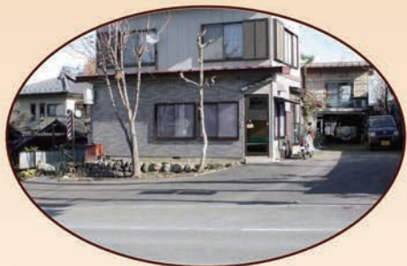
個人様宅の駐車場舗装施工例
