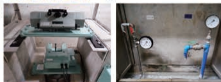
▲ 堤内観測設備(プラムラインと漏水量・揚圧力計)
