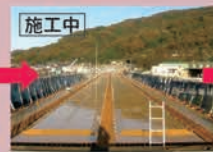
コンクリート打設前の型枠組立 コンクリート打設前の鉄筋組立
