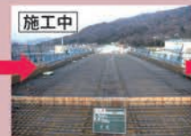
コンクリート打設前の型枠組立 コンクリート打設前の鉄筋組立
